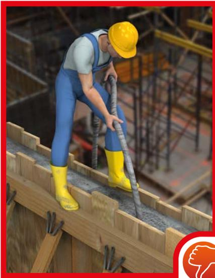
*Betonverdichtung bei einer Ortbetonwand*
